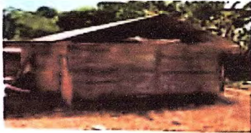
Foto 1: Muestra estado del mantenimiento de la escuela
